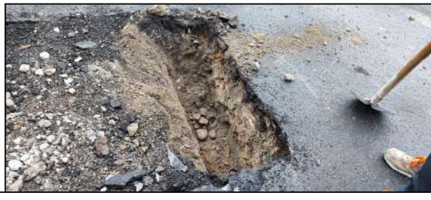
stralcio 1: esempio di esecuzione dei sondaggi preliminari
