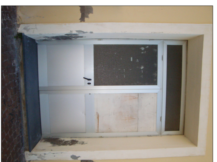
SERRAMENTI IN ALLUMINIO DA SOSTITUIRE
