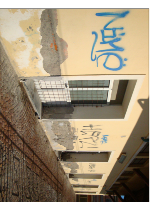
PROSPETTO SUD INTONACO DA RIPRISTINARE
