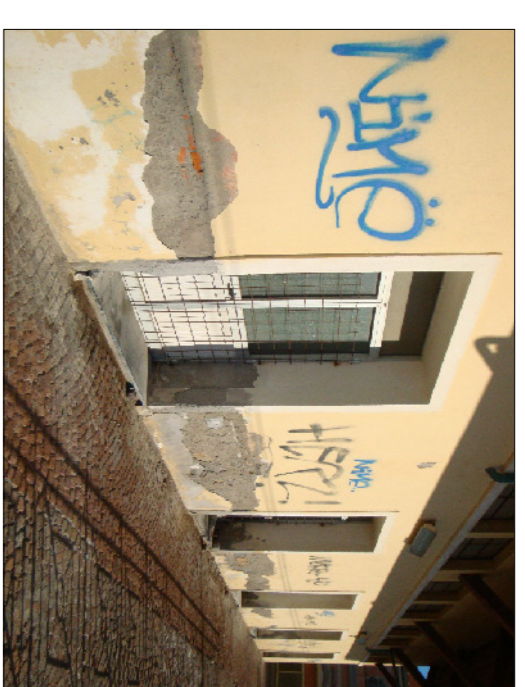
PROSPETTO SUD INTONACO DA RIPRISTINARE
