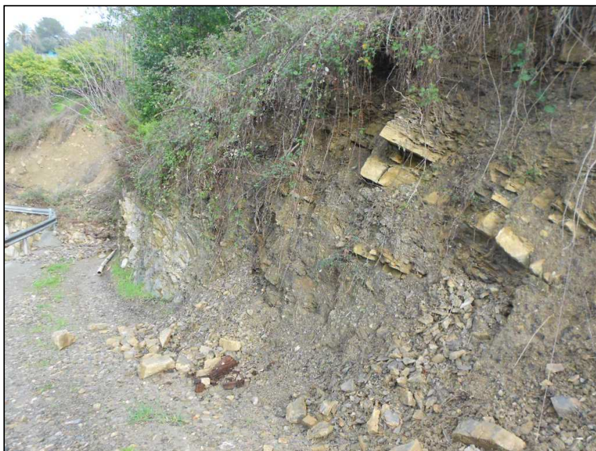
Figura 5 Cedimenti di parete lungo la pista di accesso alla briglia.
