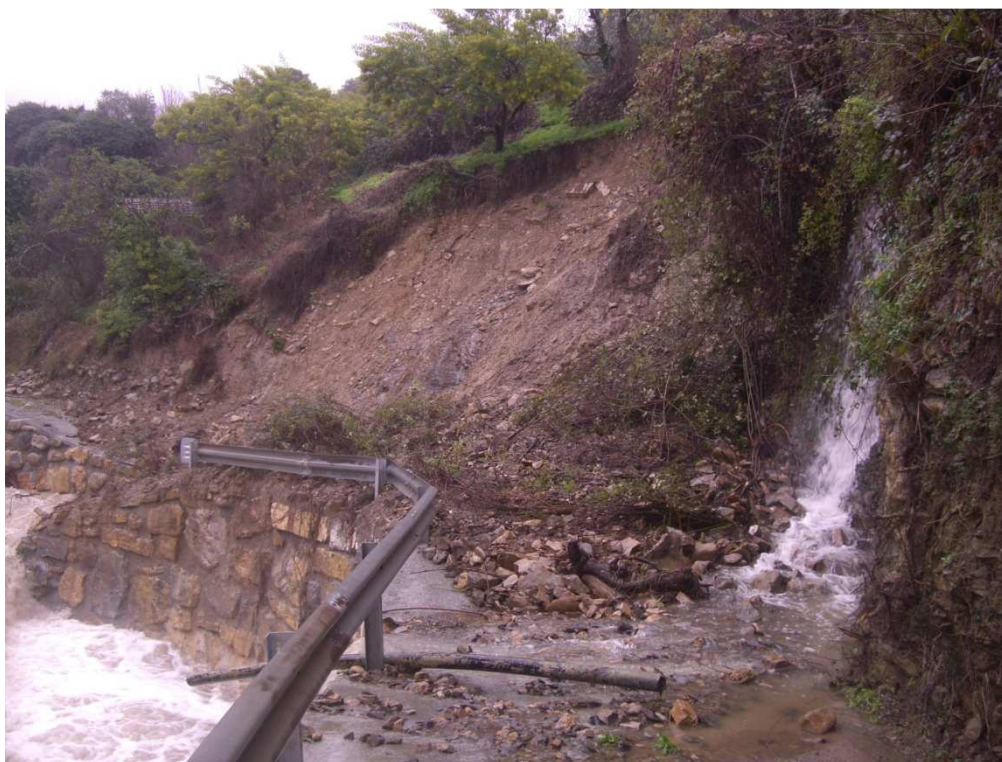
Ripresa dalla pista di accesso con dettaglio dell'acqua ruscellante lungo l'impiuvio in sinistra del corpo frana
