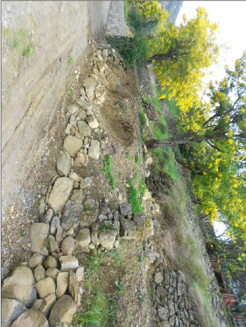
FOTO 3 - MURETTO IN MASSI SCIOGLTI CROLLATO LUNGO LA PISTA DI ACCESSO ALLA VASCA DI TRATTENUTA
