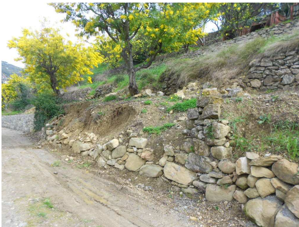
Tratto di muretto a secco lungo la pista di accesso, parzialmente dissestato
