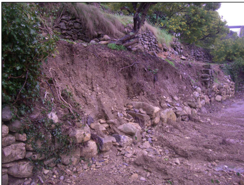
Figura 6 Cedimenti di parete lungo la pista di accesso alla briglia.
