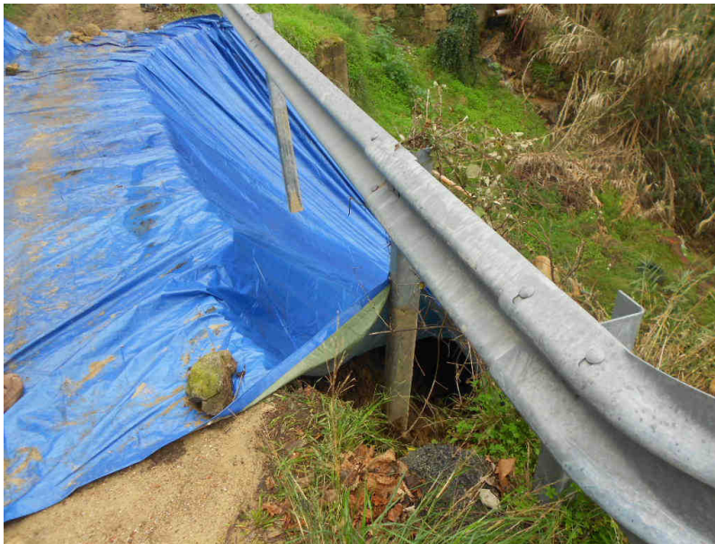
Figura 3 Dettaglio del guard-rail sospeso a seguito dello svuotamento a causa del dissesto
