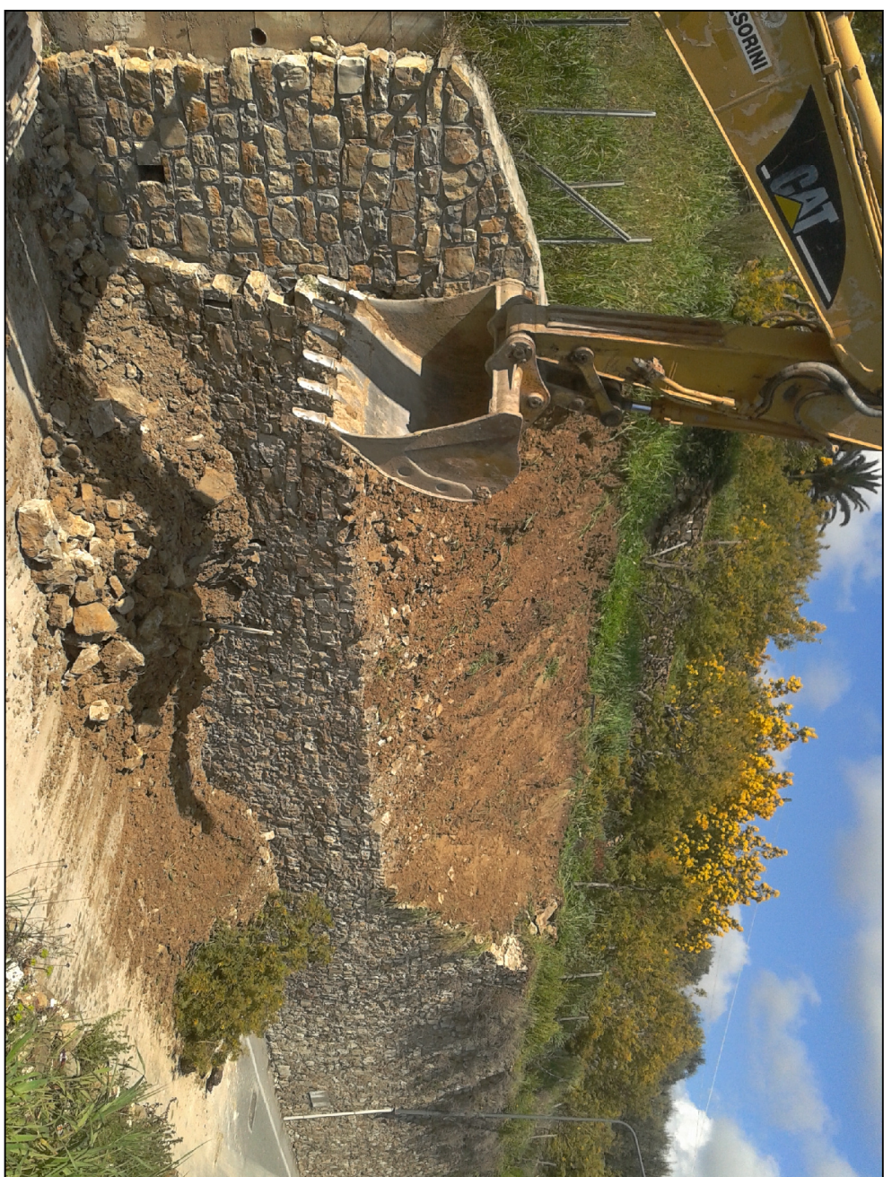
MURO IN PROGETTO DA RICOSTRUIRE E MURO IN CEMENTO ARMATO ESISTENTE DA RIVESTIRE IN PIETRA
