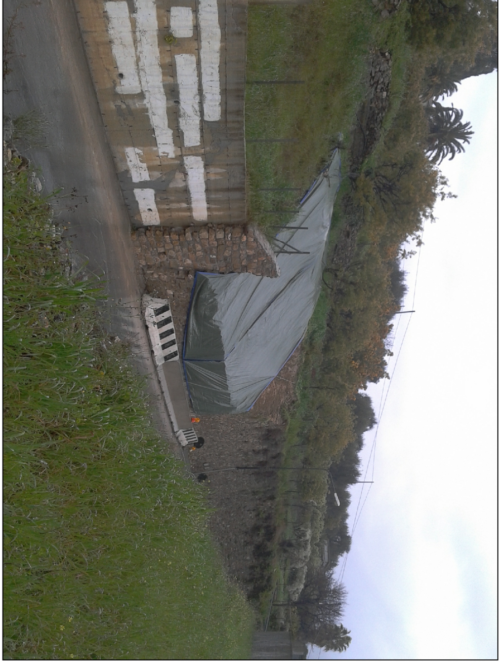
MURO IN PROGETTO DA RICOSTRUIRE E MURO IN CEMENTO ARMATO ESISTENTE DA RIVESTIRE IN PIETRA
