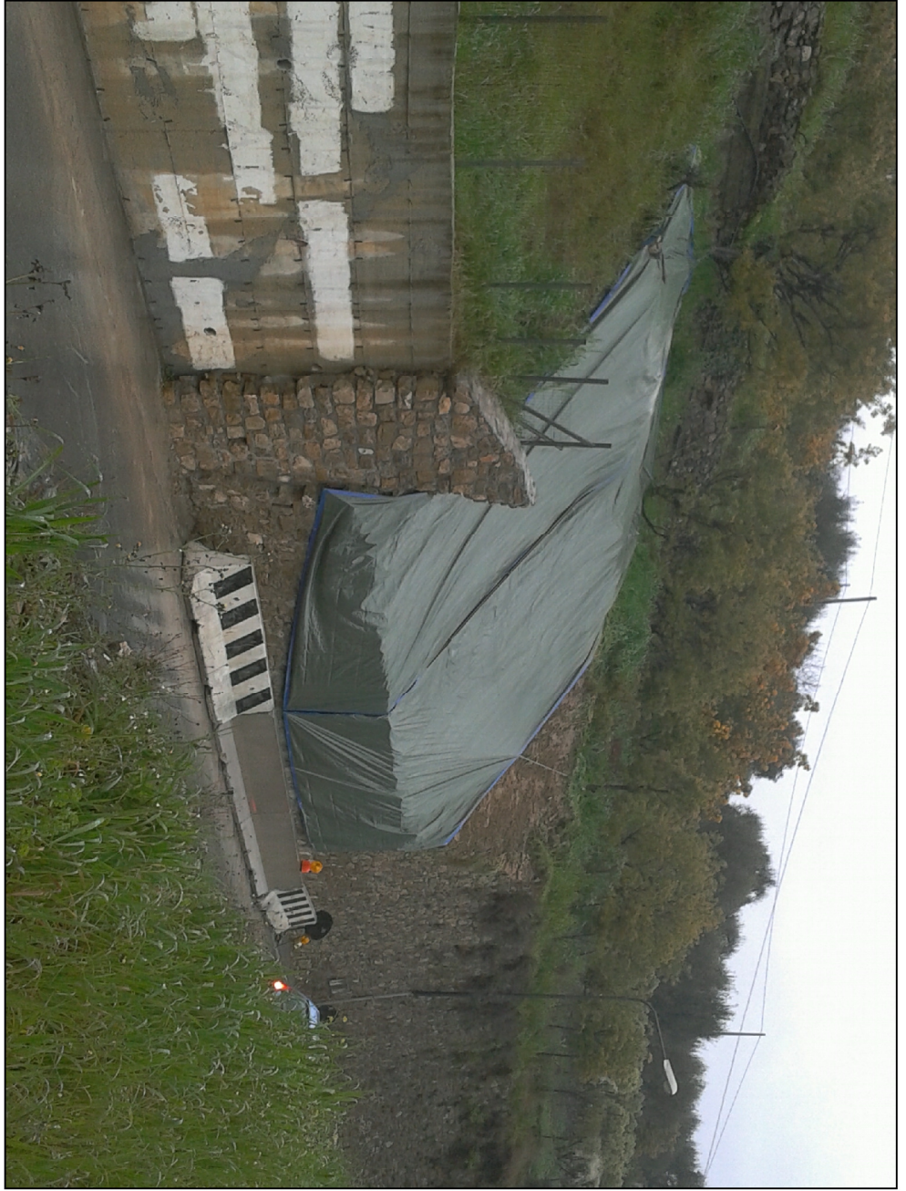
MURO IN PROGETTO DA RICOSTRUIRE E MURO IN CEMENTO ARMATO ESISTENTE DA RIVESTIRE IN PIETRA
